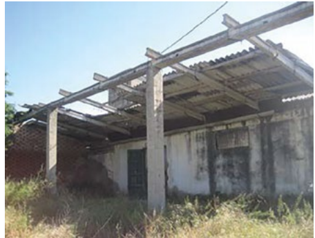
Zuntz-zementuzko estalkia nabarmen hondatua. Iturria: Lan Arriskuen Prebentziorako Atala. NOPLOI.
