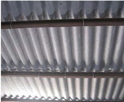
Zuntz-zementuzko estalkiaren behealdeko ikuspegia. Metalezko egitura kontserbazio-egoera onean dago. Iturria: Lan Arriskuen Prebentziorako Atala. NOPLOI.
