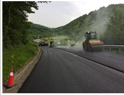
Trabajos de embreado.
