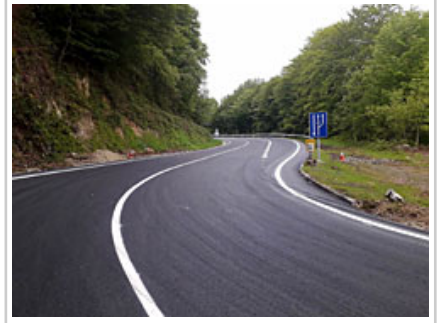
Desdoble del carril en el PK. 8.
