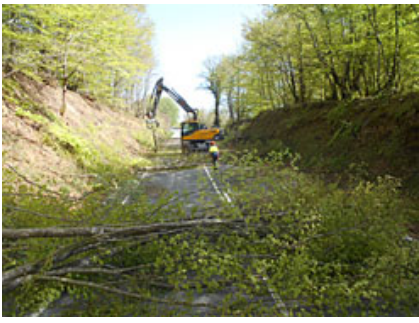
Desbroce de los márgenes de la NA-1210.
