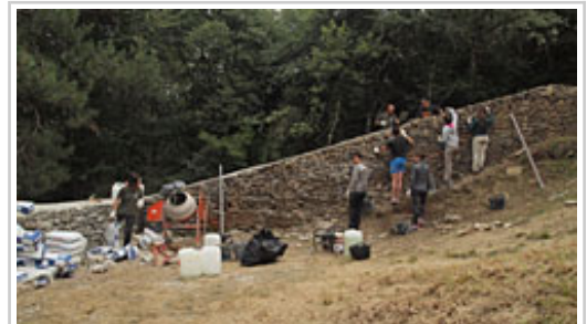
Monitore eta gazteak harresi bat finkatzeko lanetan ari dira.
