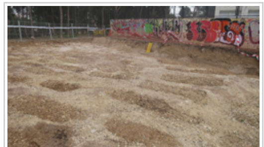
La parcela donde se están ejecutando los trabajos.
