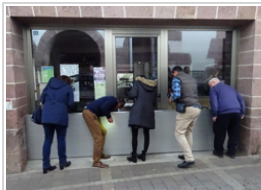
Vecinos de Sunbilla colocan una compuerta.
