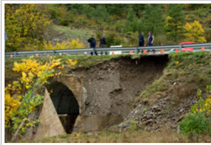
Vista del estado actual del puente sobre el río Biniés.
