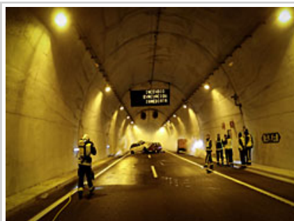
Aviso del accidente en la señalización lumínica del túnel
