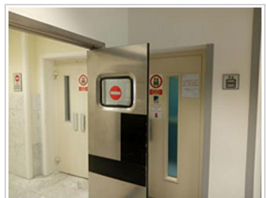
Ascensores del Hospital García Orcoyen
