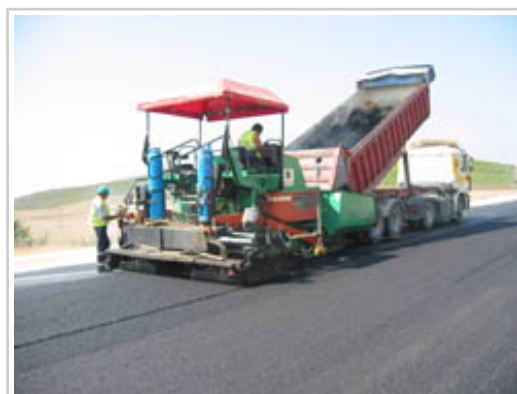
Obras en una carretera.
