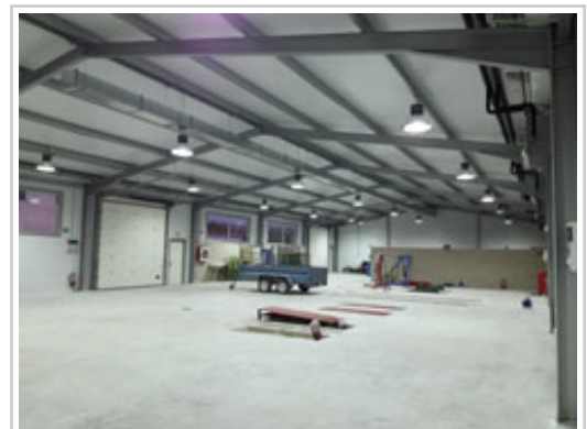
Construcción de la nueva nave de automoción en el IES Huarte.
