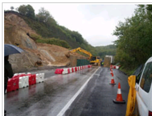
Trabajos de reparación en la N-121-A (Pamplona-Behobia).
