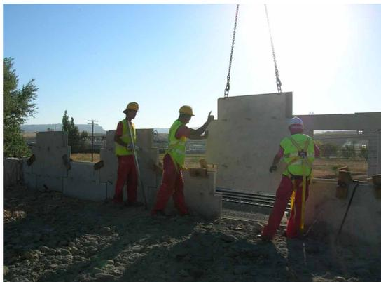
Ilustración 3. Instalación de paneles de tierra armada.
