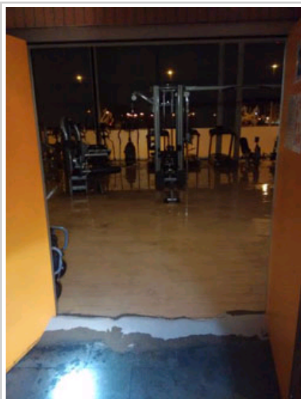
La sala de aparatos de gimnasia, inundada.
