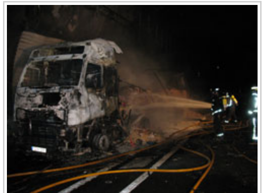
El incendio de un camión en el túnel de Belate impide su uso.
