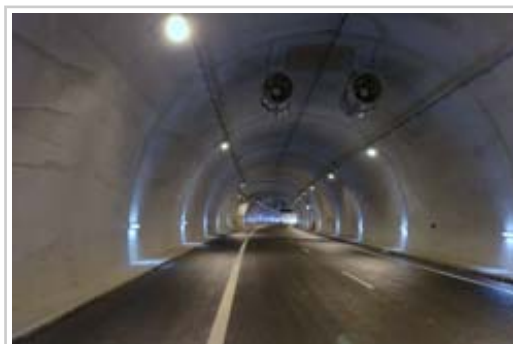
Interior del túnel de El Perdón, en la A-12 (Autovía del Camino).
