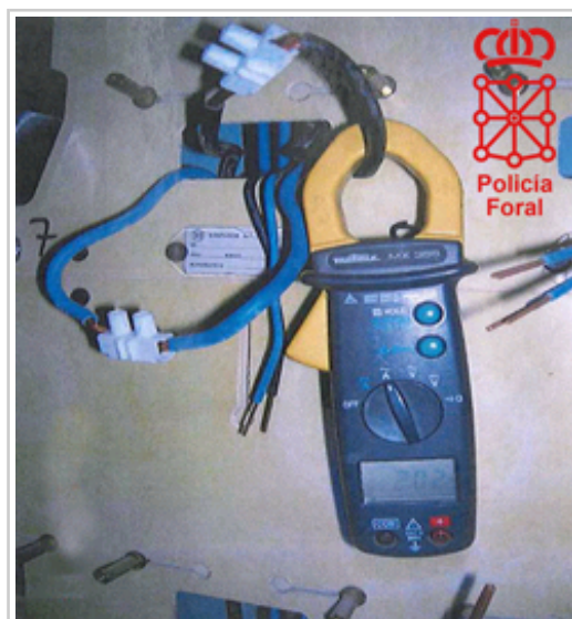
Manipulación realizada por uno de los detenidos para conectarse directamente a la red sin contrato ni contador.
