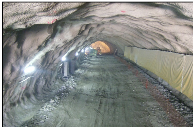
Vista interior del túnel
