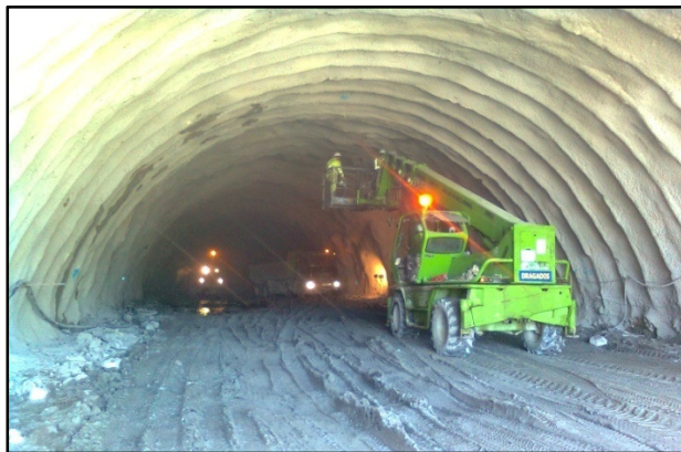
Trabajos en el interior del túnel
