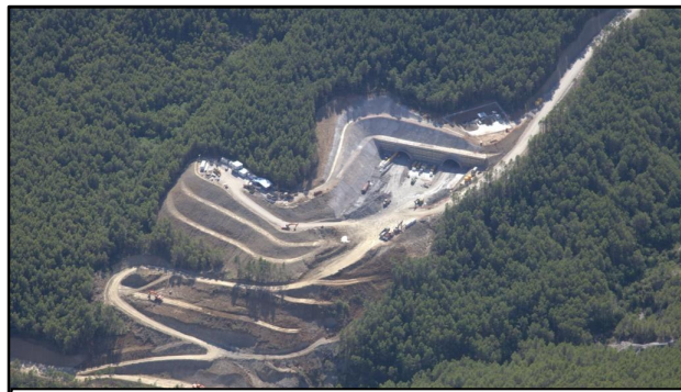
Vista aérea del emboquille Jaca
