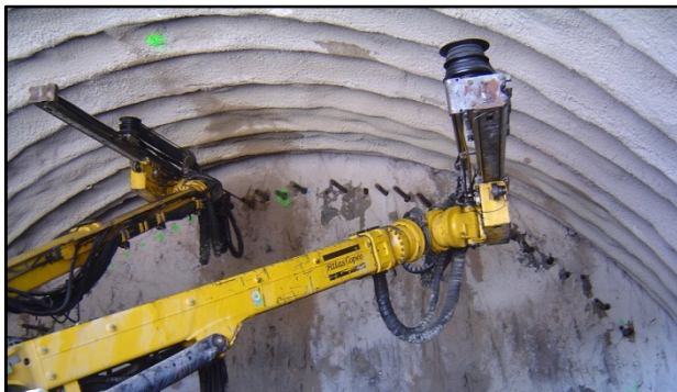
Perforación paraguas de micropilotes
