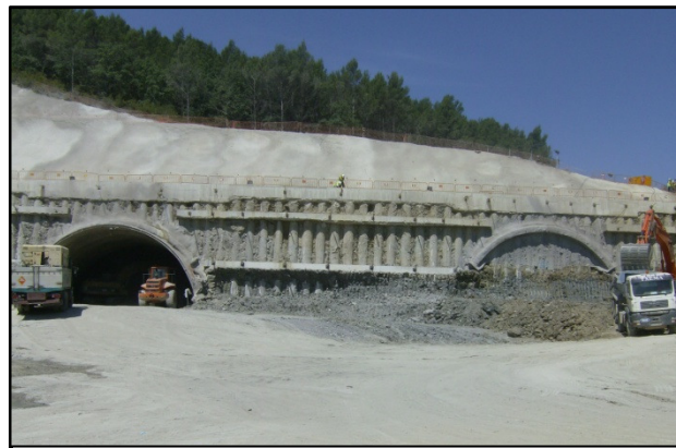
Inicio de excavación en el emboquille Jaca
