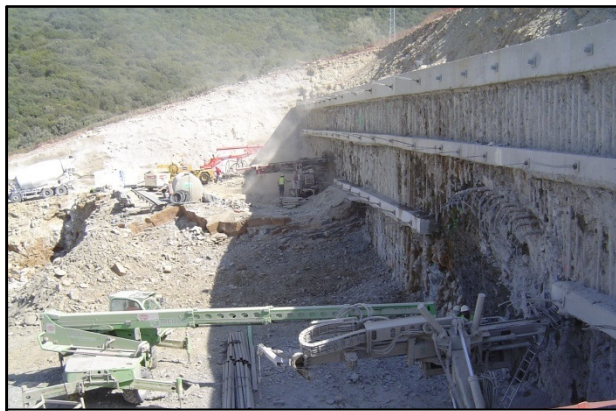
Trabajos en la pantalla del emboquille Pamplona
