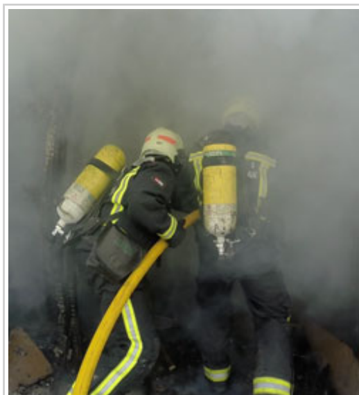
El fuego ha dañado la estructura de la casa.
