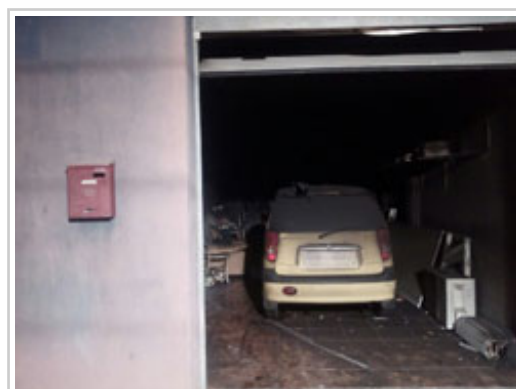
Imagen del garaje donde se ha producido el incendio.
