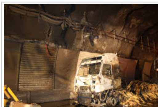
El camión incendiado, en el interior del túnel.
